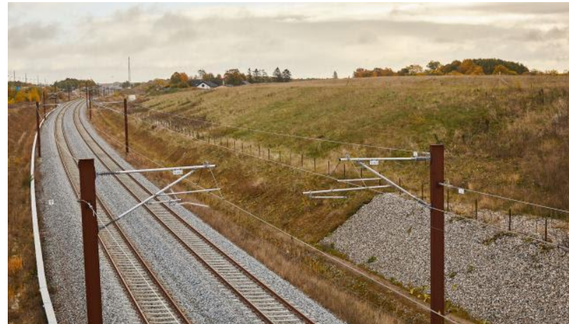
Abb. 5: Beispiel für Corten-Stahlprofilmaste, nach [1]
