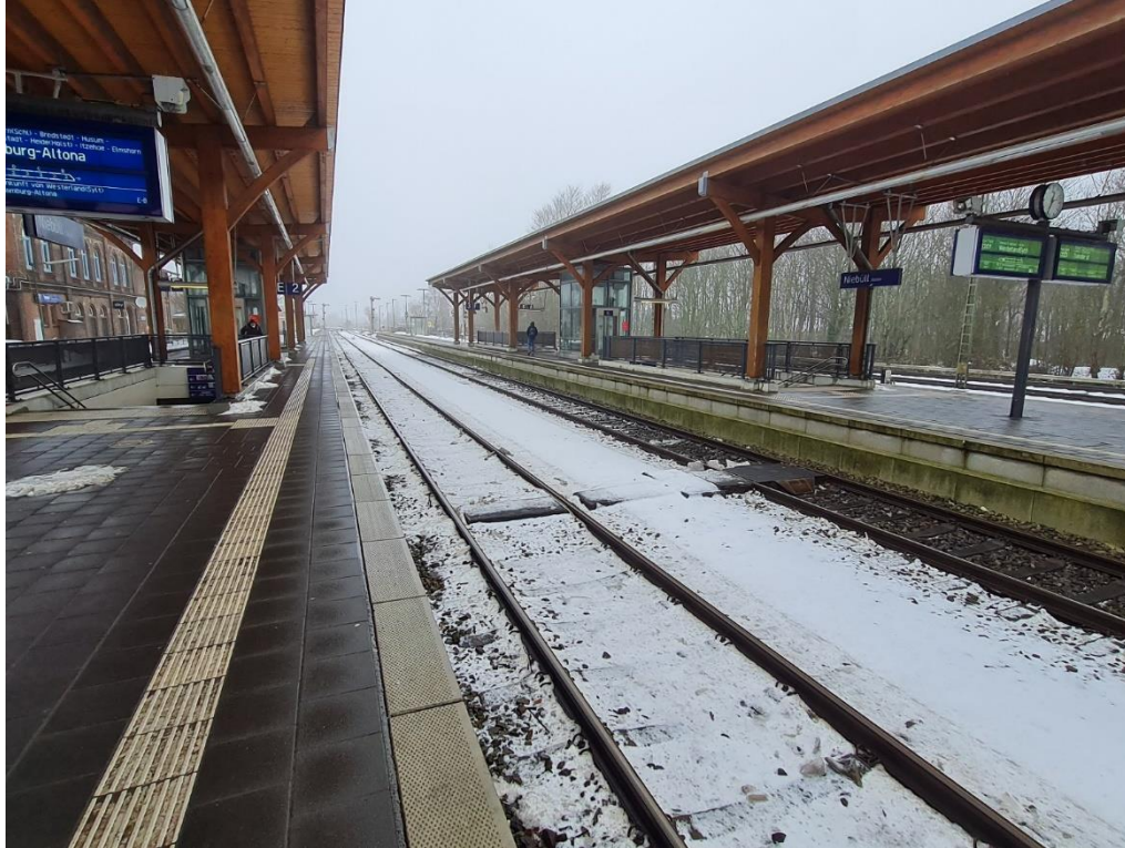
Abb. 3: Bahnsteigüberdachung Bf Niebüll DB
