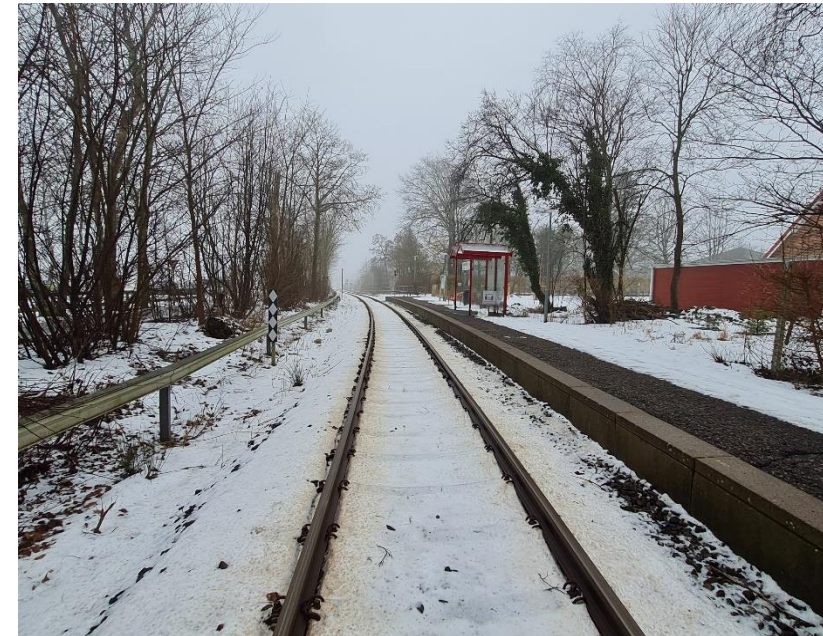
Abb. 14: Beispiel Kabeltrog (links)
