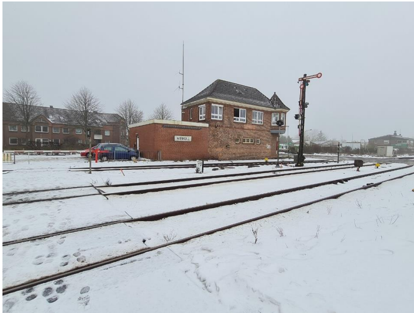
Abb. 13: Stellwerk N1 Bf Niebüll
